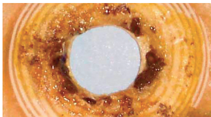
Fuites sous support
